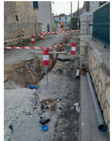
Enfouissement des réseaux dans le quartier Les Bertons.
