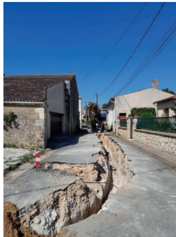
Enfouissement des réseaux dans le quartier Les Bertons.
